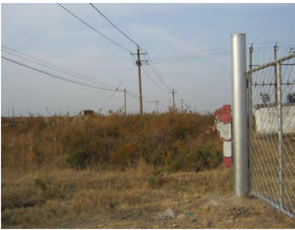
郑 411-平 121 井场临时占地恢复情况
